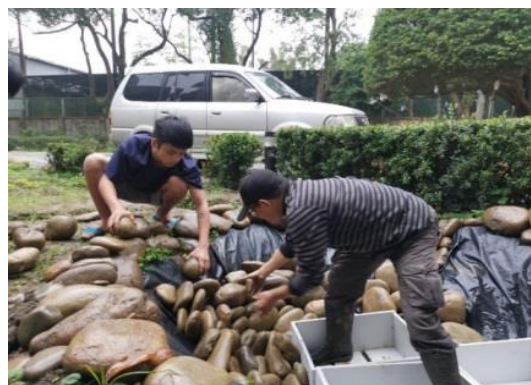
將預作好的植栽槽放入生態池內，利於後續植栽盆的放置，並以人力傳遞石頭的方式，將石頭堆砌於池內。
