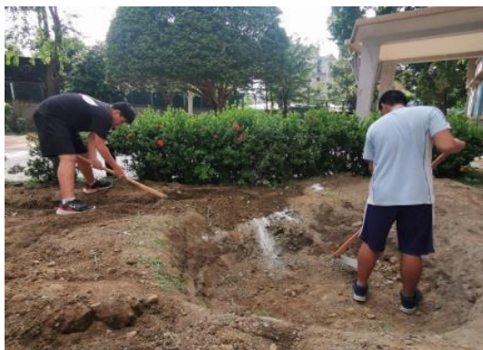
底部土方平整後將水撲滿放入坑內。
