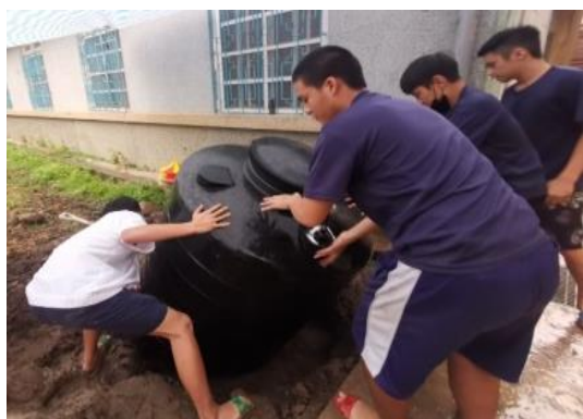
底部土方平整後將水撲滿放入坑內。
