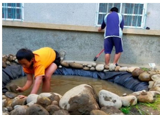
將生態池的預定地以石灰放樣完成，並確認深度後進行挖掘，過程中有挖掘到電路管，需重新規劃原先調整生態池之範圍，並以黃色水管示警電路管位置回填土方。
