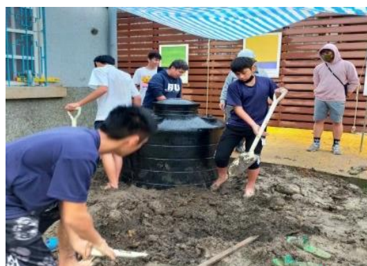
進行土壤夯實，讓水撲滿更加穩固。
