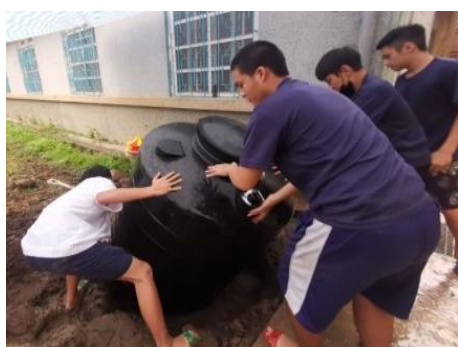
底部土方平整後將水撲滿放入坑內。
