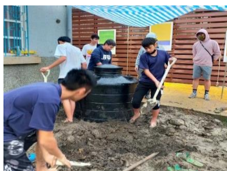
進行土壤夯實，讓水撲滿更加穩固。
