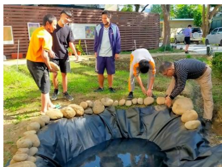
依照生態池之大小及形狀鋪設適當的帆布，後續進行灌水測試，確保生態池無漏水。
