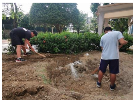
將生態池的預定地以石灰放樣完成，並確認深度後進行挖掘，過程中有挖掘到電路管，需重新規劃原先調整生態池之
