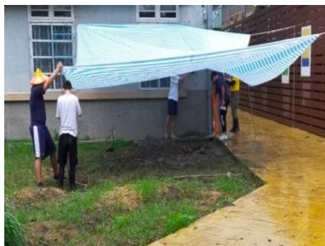
雨水撲滿施工前放樣與測量，因施作當天陰雨不斷，師生協力建置臨時雨遮。
